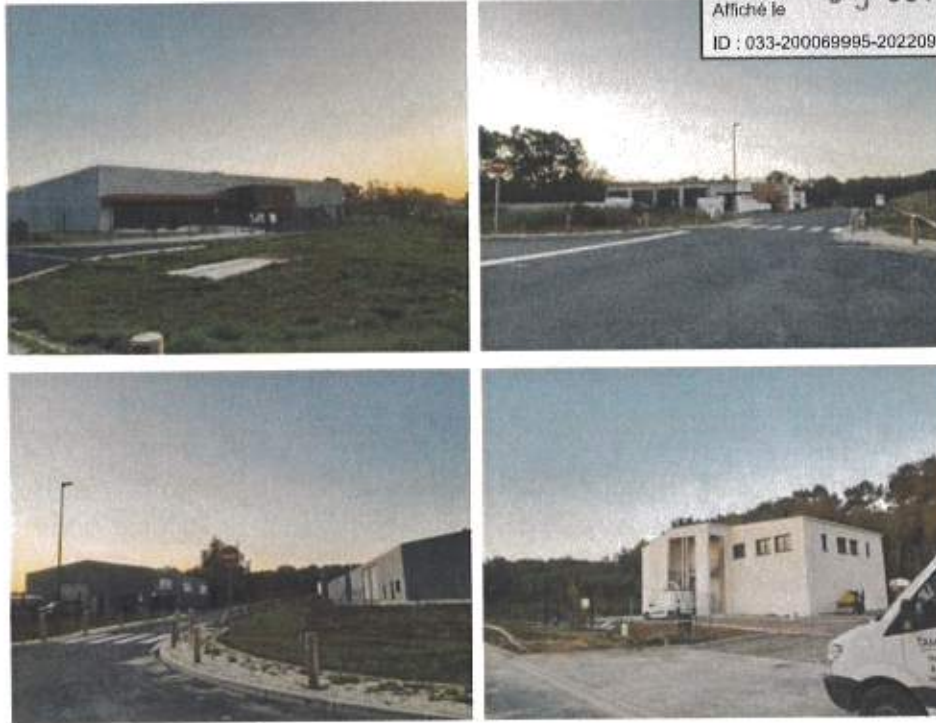
Entreprises de l'extension de la ZA Lamothe à Saint-Laurent Médoc, 2021
